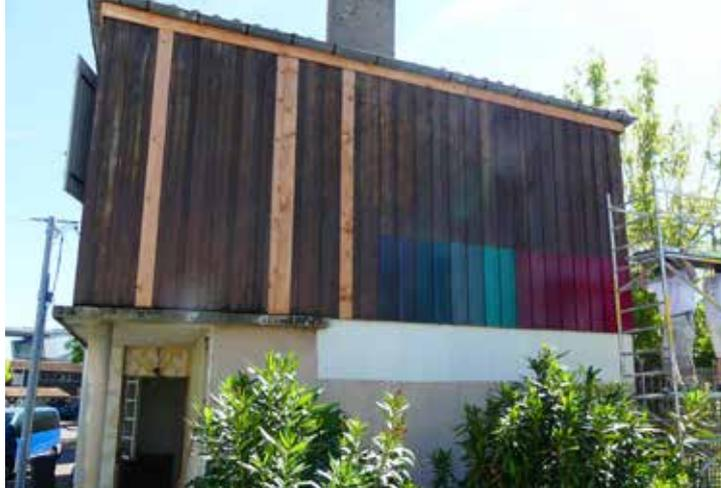
Façade d'une maison prototype avec des nouvelles lames de bardage et les tests de peinture
