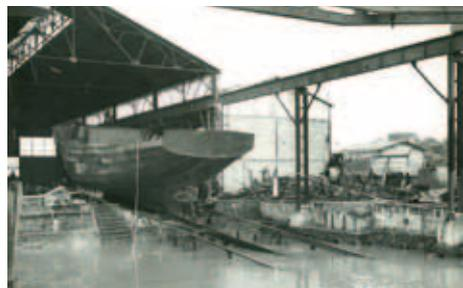
▲ Une coque en construction prête à être mise à l'eau (archives Sarthoulet).
